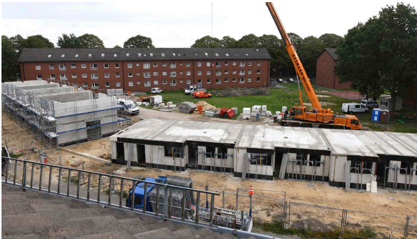
Neuland: Der erste serielle Neubau der STÄWOG im Engenmoor nimmt Form an.
